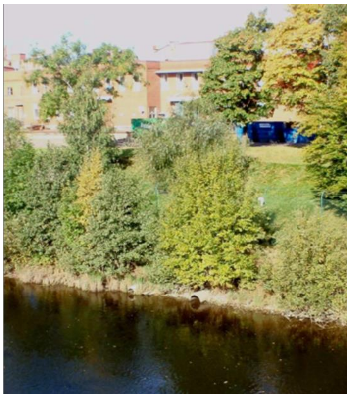
Figur 2 Exempel på dagvattenutlopp samt den gröna zonen med vegetation närmast Sävån. (Foto Norconsult)
